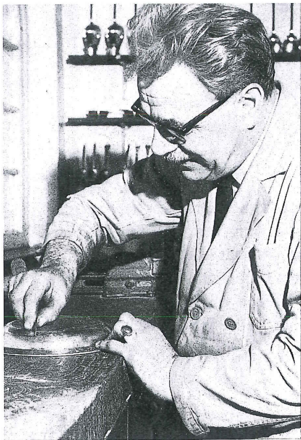
Het schrappen van het tinnenbord, een belangrijke nabewerking om het produkt zijn finishing touch te geven.
