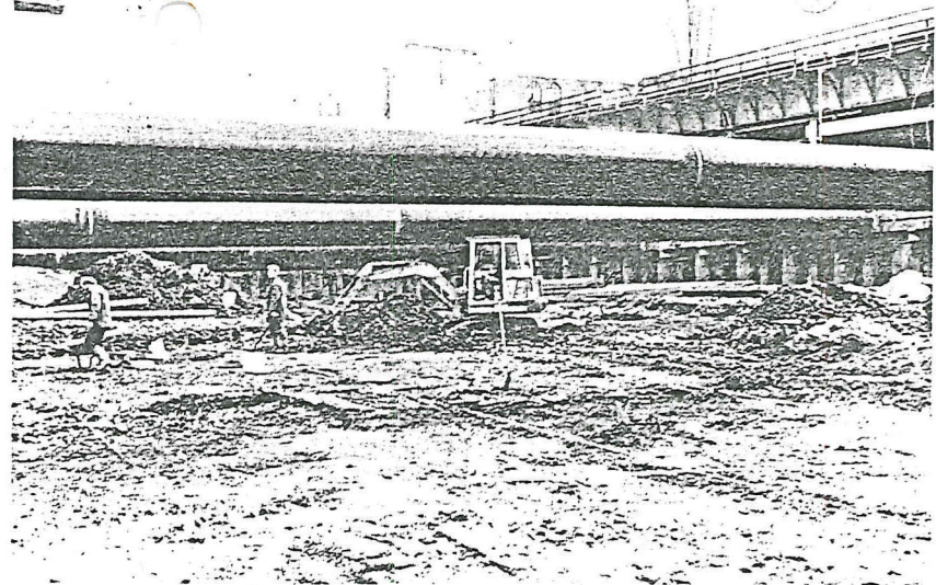
3. Opgraving Jacobsplaats. Alvorens met de grote graafmachine kan worden gewerkt, moet eerst met een mini-graafmachine ruimte worden gemaakt.
