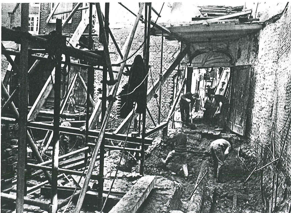
tentoonstellingsgebouw tijdens de restauratie
